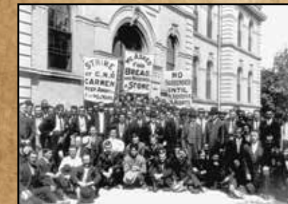
Circa 1915 - Travailleurs des ateliers ferroviaires en grève, Winnipeg.
