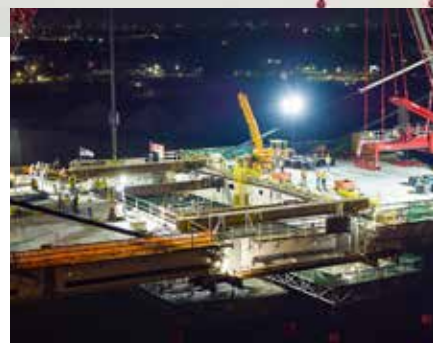
▲ Le projet du pont Gordie Howe sera achevé et ouvert à l'automne 2025.
