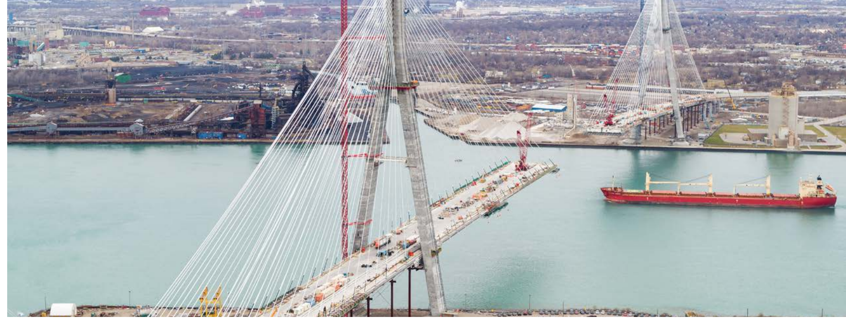
▲ Le projet du pont international Gordie-Howe à Windsor, Ontario, Canada. / Progrès en date de décembre 2023 / Gracieuseté de Gordie Howe Inter. Bridge
