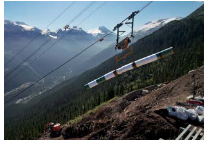
▲ Cet été, Coastal GasLink a installé environ 1 400 mètres de canalisations dans ce que le programme appelle le « Cable Crane Hill » dans la « Section 8 ».
